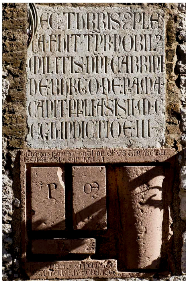
BILD 19 Standardmaße für Stoffe und Ziegelformen am Palazzo del Capitano
