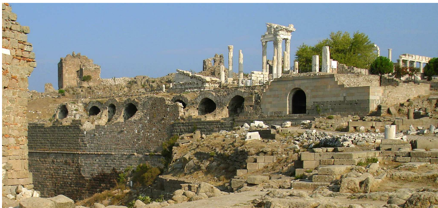
BILD 61 Tonnengewölbe tragen die Terrasse des Traianeums in Pergamon
