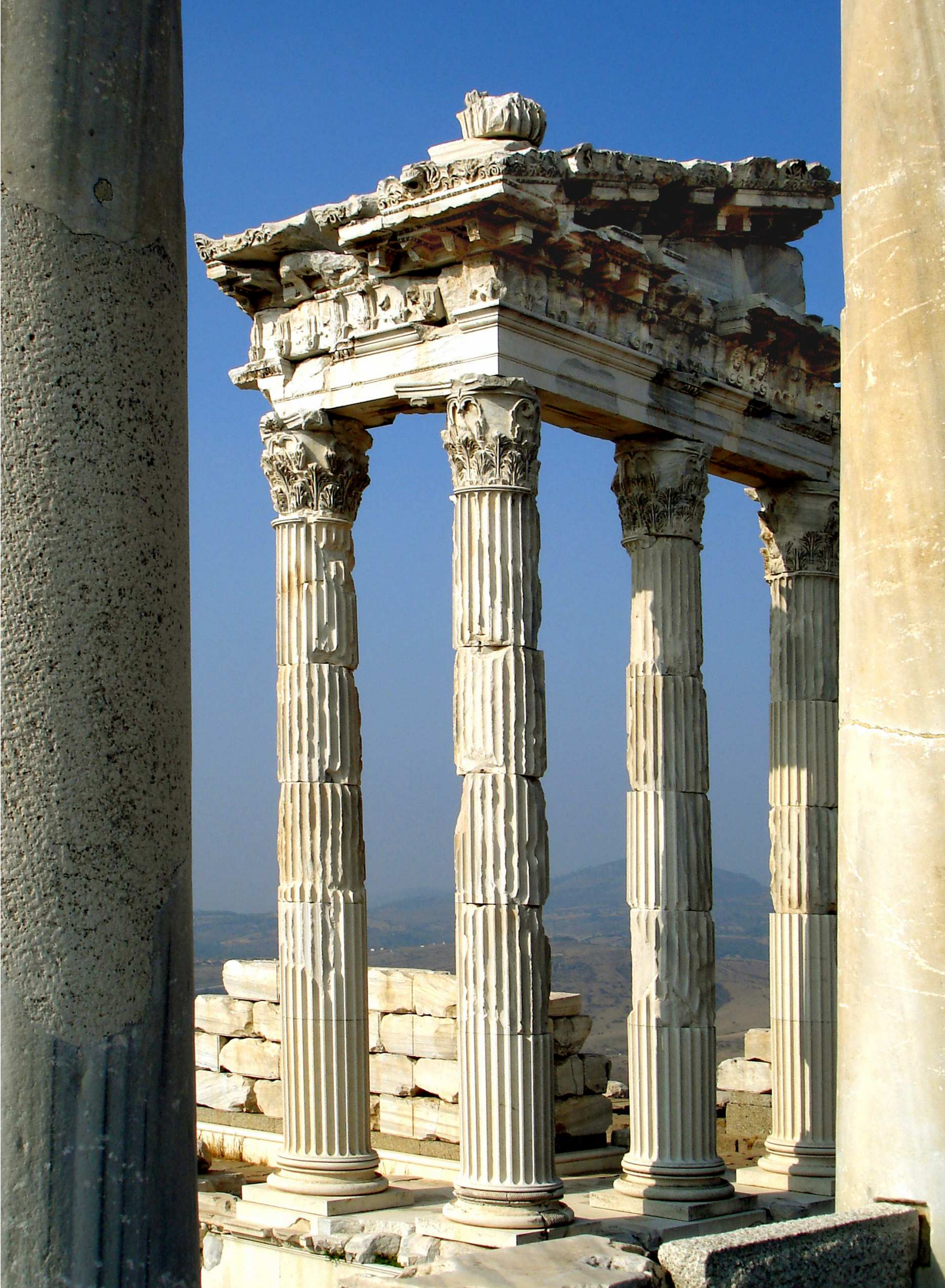
BILD 65 Blick durch die Säuleneinfassung auf den Traianstempel
