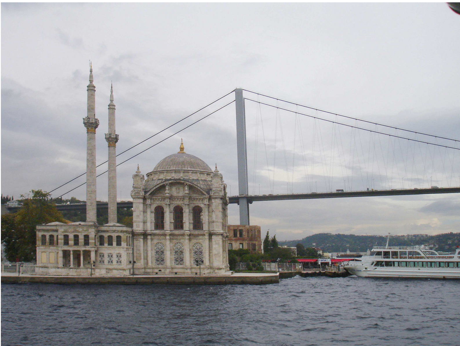
BILD 49 Ortaköy Camii an der Bosphorusbrücke
